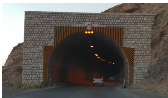
شکل ۳. نمایی از ورودی تونل پنجم
