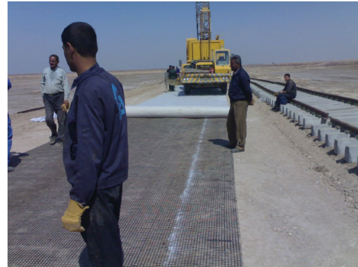
شکل ۳. روند نصب ژئوتکستایل و ژئوگرید
