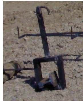
شکل ۵. قلاب نگهدارنده خرپا
