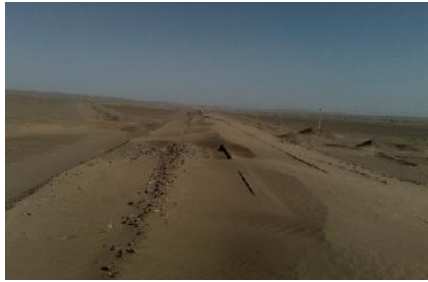
شکل ۱. ورود ماسه به خط آهن
