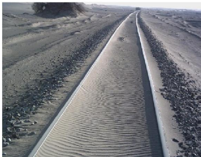
شکل ۲. ورود ماسه و انباشت روی خطوط
