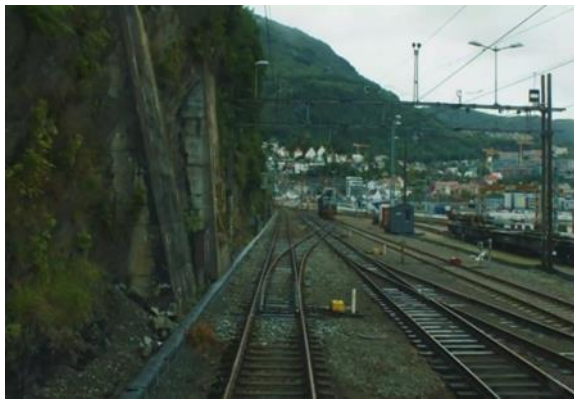
شکل ۸. یک نمونه سوزن و مسیریابی با توجه به جهت سوزن
