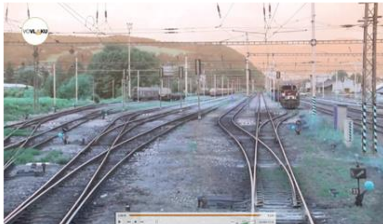
شکل ۱۸. یک نمونه تصویر که در آن دو سوزن بسیار نزدیک به هم در مسیر حرکت قطار، قرار دارند.
