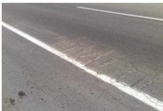
شکل ۱۷. نمونه‌ای از خرابی‌ها در حدود ۶ ماه پس از بهسازی شامل ترک‌های خستگی و نشست موضعی به همراه آثار ریزدانه در اطراف ترک، قطعه ۲، کیلومتر ۲۹+۷۰۰، سال ۱۳۸۶
